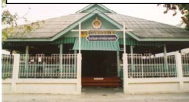
อาคารโรงโขน
